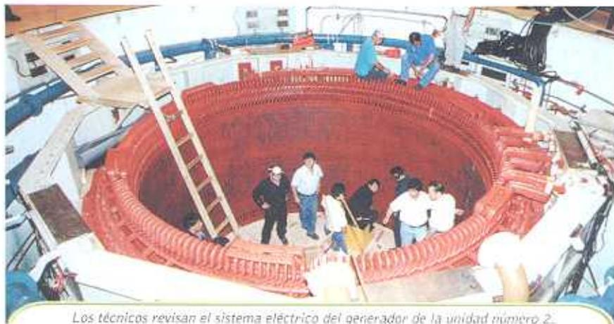
Los técnicos revisan el sistema eléctrico del generador de la unidad número 2.
