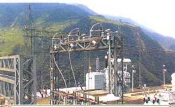
Seccionadores de 13.8 KV, en las fronteras con Transelectro:
