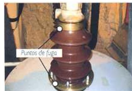
Fugas de aceite corregidas en el transformador de la unidad Nro. 8
