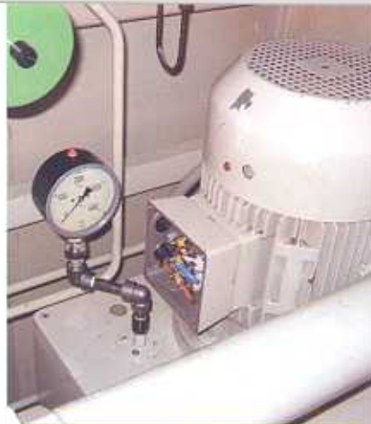
Motor del sistema de frenos y gatos en su nueva posición, en la unidad 05.
