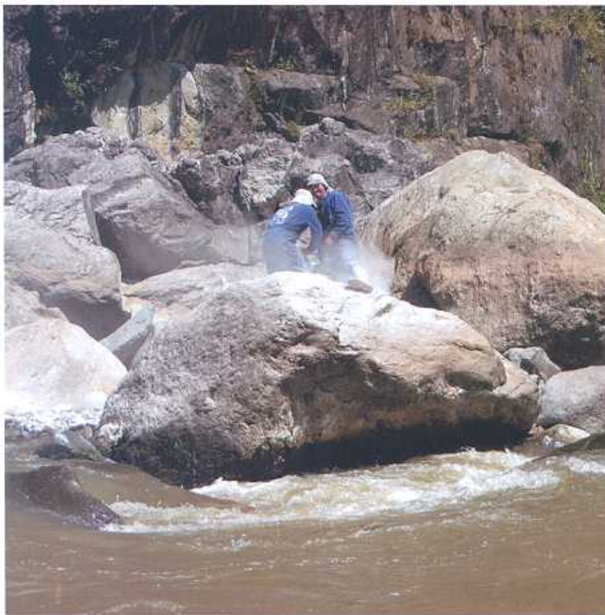
Destrucción de grandes piedras mediante explosiones para encauzar el río, al pie de Guarumales.
