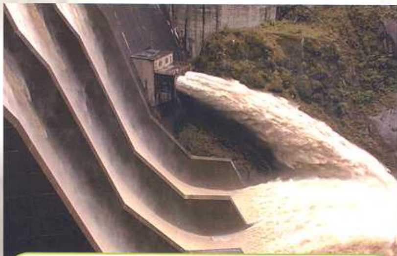
Vertederos y desague de fondo de la presa Daniel Palacios.
