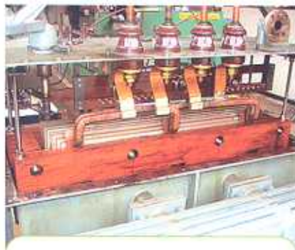
Transformador de 250 KVA, 13,8 KV en reparación.
