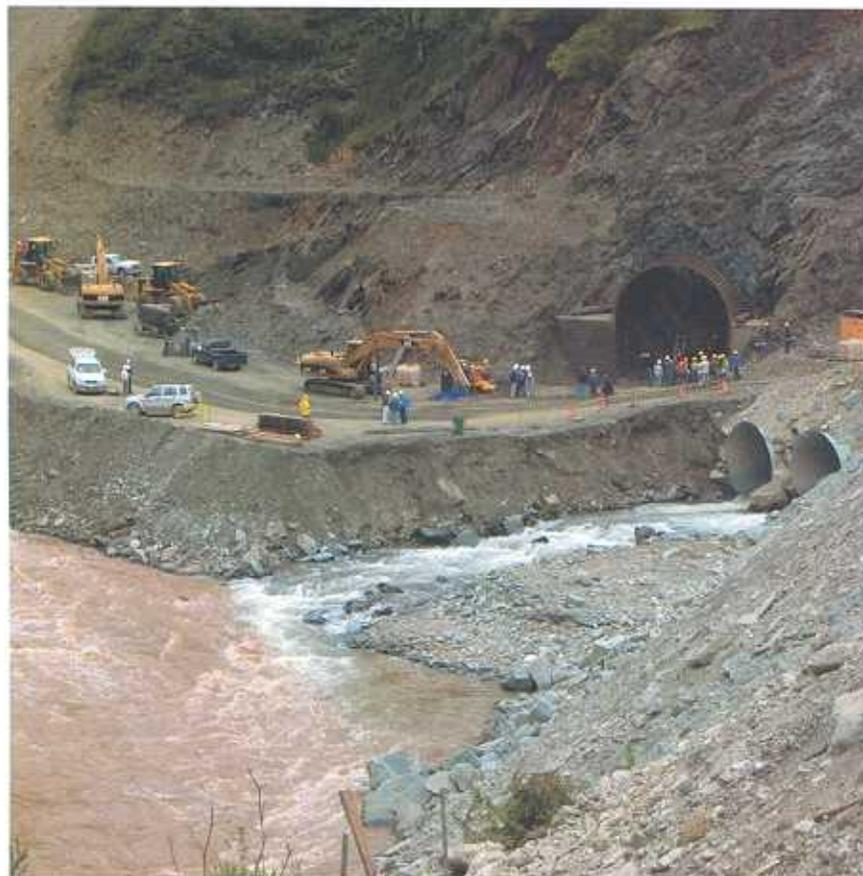
Excavación del túnel de desvío del río Paute, en la intersección con el Mazar, para secar el lecho sobre el cual se levantará la presa de Mazar.
