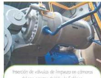
Inserción de válvulas de limpieza en cámaras del servomotor de Válvula Esférica.
