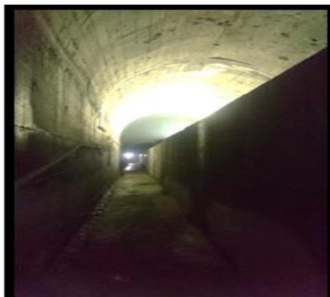
Hormigón empacado en túnel sub horizontal.
