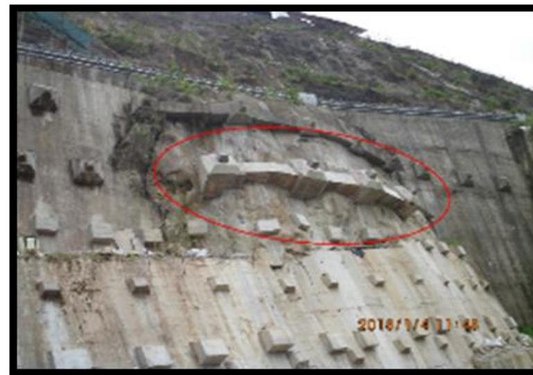
Instalación de cables postensados de 200 Ton en la cota 1488 msnm concluidos
