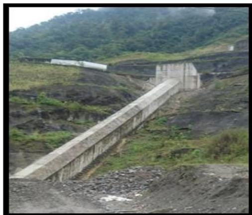
Hormigón empacado en tubería inclinada finalizado.
