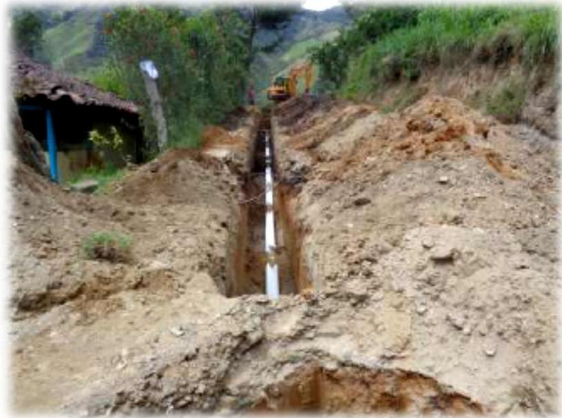
DETALLE DE OBRA: Instalación tubería para alcantarillado sanitario en la parroquia Imbana.
