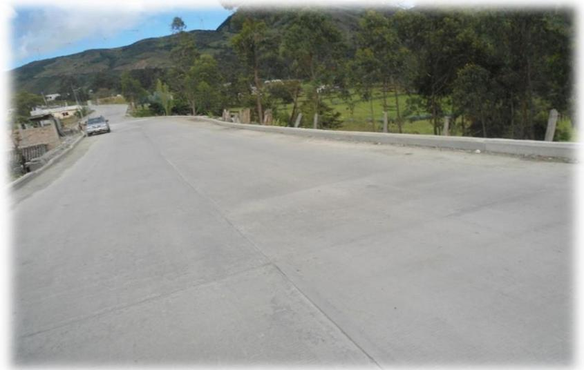
**DETALLE DE OBRA:** Construcción de vía de pavimento rígido desde el kilómetro 11 de la vía antigua Loja-Catamayo, con enlace a los barrios: Eucaliptos, El Plateado y Bolonia. Con una longitud de 5,5 km.
