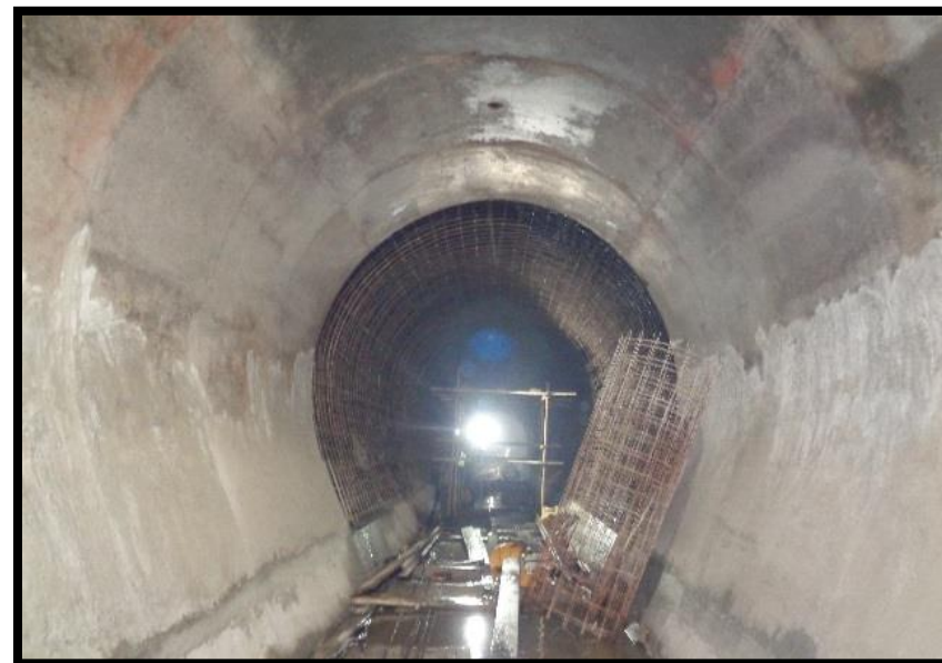
Hormigonado del túnel de carga
