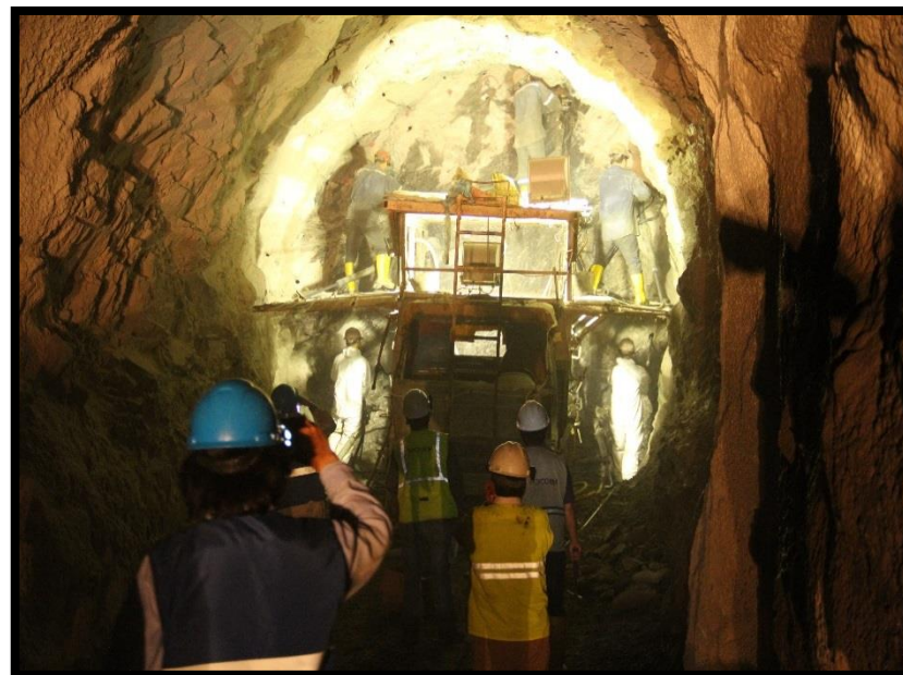
Túnel sub-horizontal del sistema de presión
