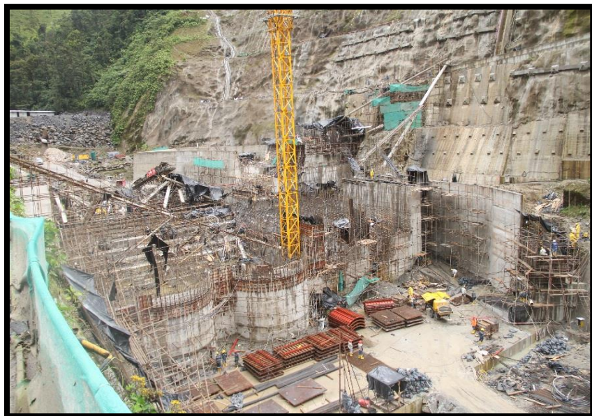
Hormigonado de la presa
