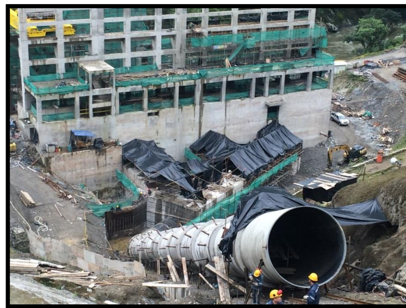
Montaje de trifurcador y tubería
