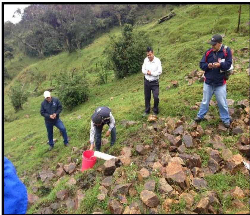
DETALLE DE OBRA: Aforo para la construcción de los sistemas de agua potable del barrio Uriguanga.
