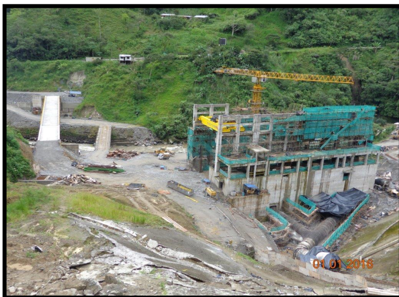
Construcción de casa de máquinas
