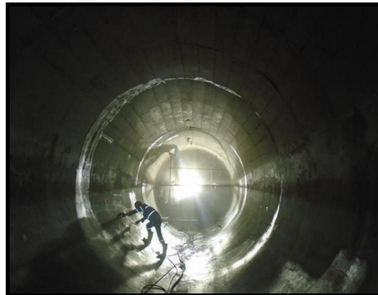
Pulido de superficie de hormigón de sección circular
