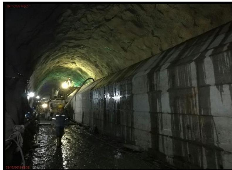
Hormigón empacado sobre tubería de presión.
