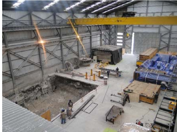
Ilustración 6 COMPACTACION PARA MONTAJE DEL TORNO VERTICAL
