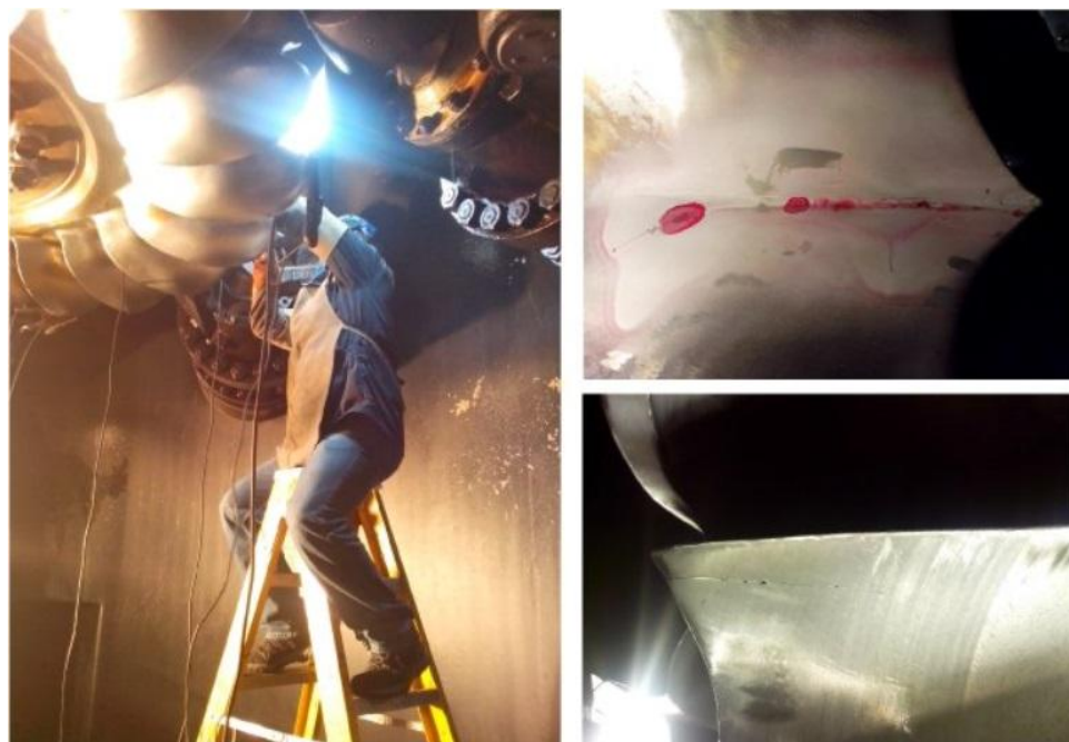
2. MANTENIMIENTO CENTRAL PUCARÁ
