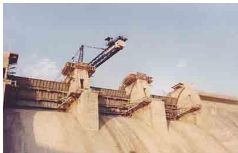
Vertedero - Estructura de compuertas. Detalle de la zona de rebose con las compuertas radiales
