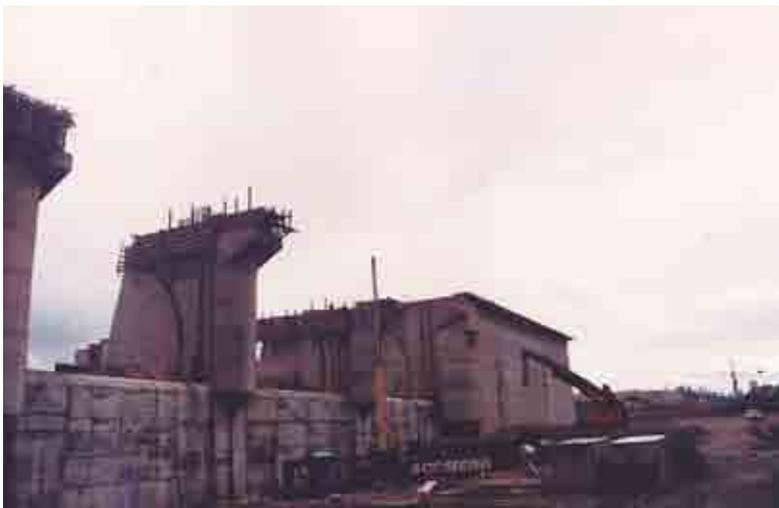
Vertedero - Estructura de Compuertas. Trabajos de desencofrado en coronaciones de pilas
