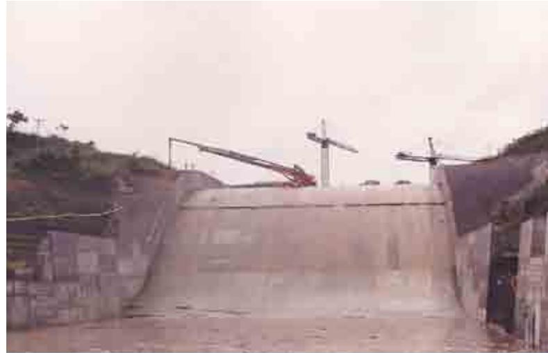
Rápida del canal del vertedero. Detalles de los trabajos de relleno del trasdós de los muros
