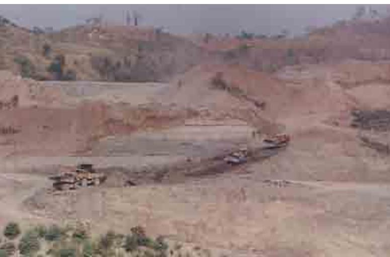
Presa - Camino a la Central. Excavación a cota de rasante final del último tramo del camino
