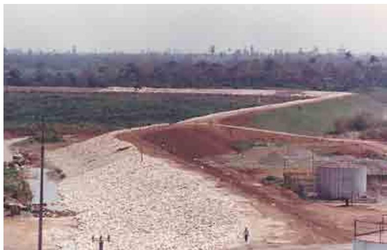
Dique de la Divisoria. Primer kilómetro del dique en trabajos de remate de enrocado
