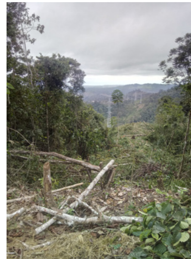
Imagen 12. Desbroce de cobertura vegetal en la franja de servidumbre de la línea de transmisión.
