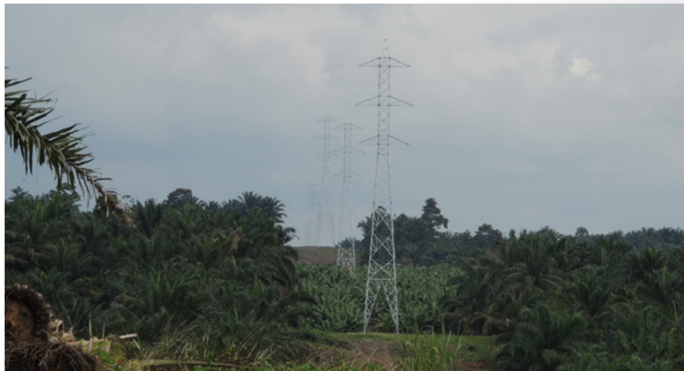
Imagen 3.- Montaje de estructura y tendido de conductores en la línea de transmisión. Fuente: GSA-CELEC EP Transelectric, 2020.
