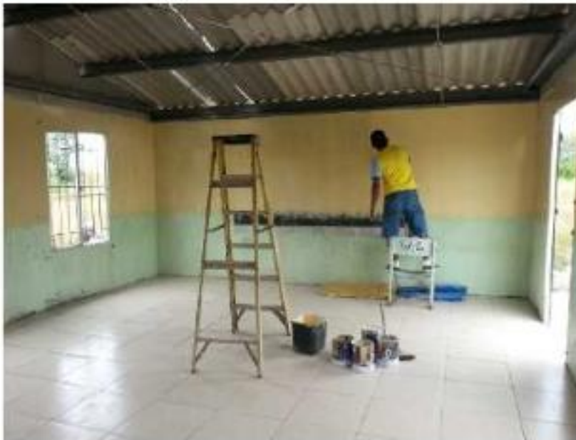
REMODELACIÓN DE ESCUELA 15 DE ABRIL EN LA PUNTILLA
