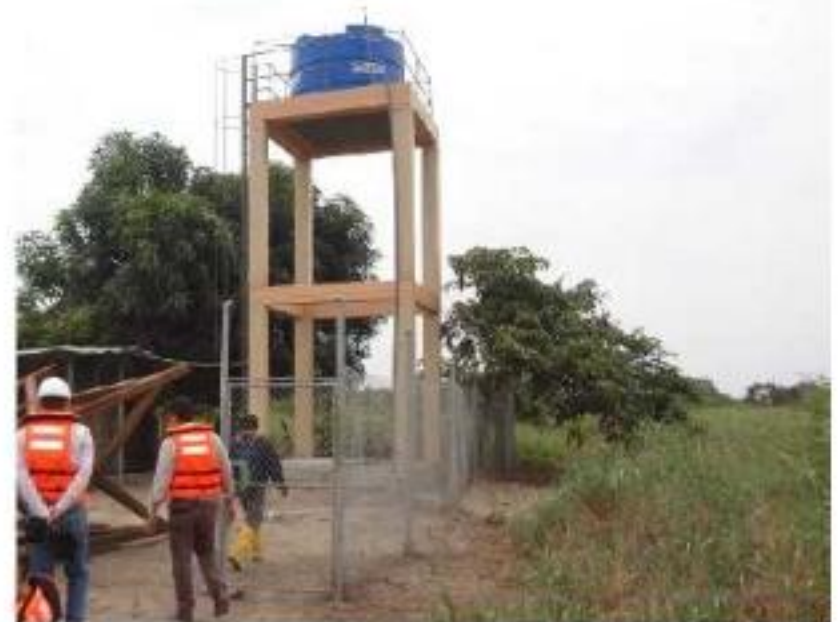
INFRAESTRUCTURA DE TANQUE ELEVADO DE LA PUNTILLA
