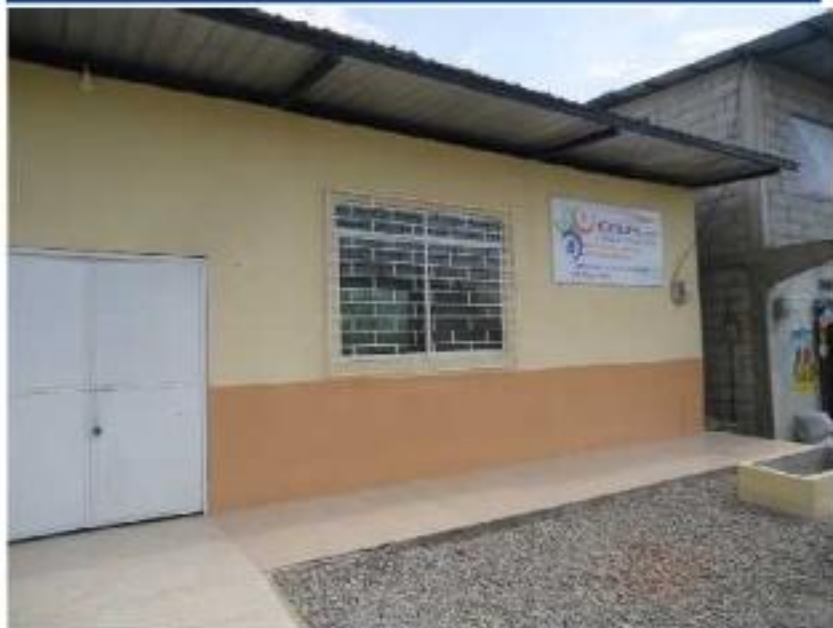
REMODELACIÓN DE CASA COMUNAL DE BAJO ALTO
