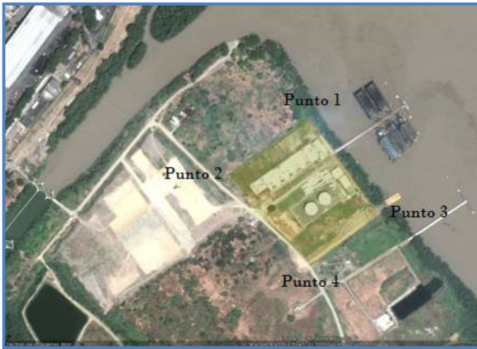
Figura 3-1 Ubicación de Termoguayas Generation S.A.
