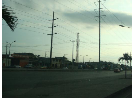
Foto 12: Tramo E11.1 – E33 (por el medio del parter)
