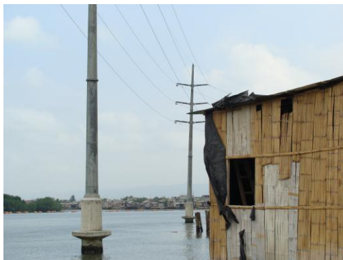
Foto 7: Estructuras dentro del estero del Muerto
