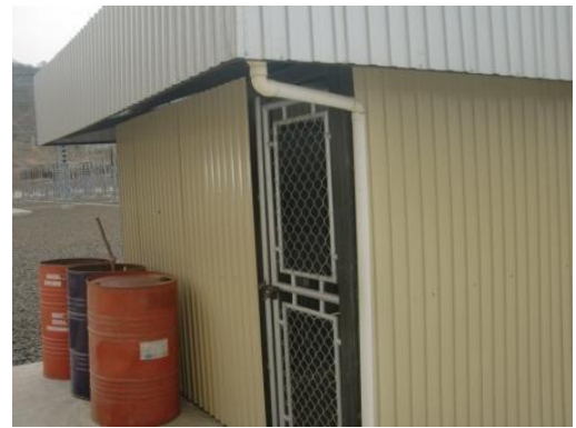
Tachos de Almacenamiento de Desechos Peligrosos – Área de Cisterna
