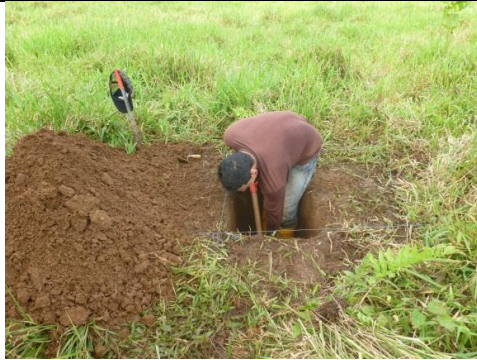
Foto 7: Excavación de cateo 1
