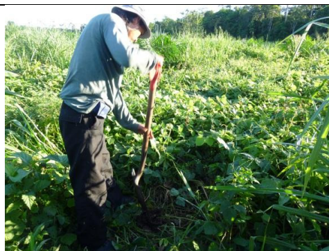
Foto 29: Limpieza para excavación
