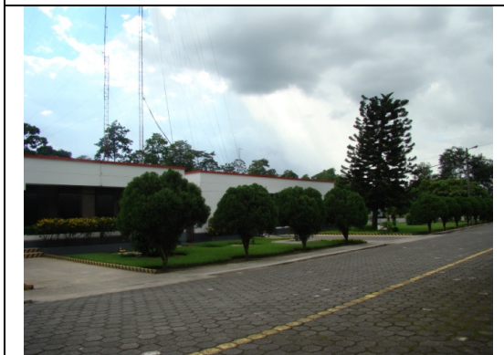
FOTO 4.3. INSTALACIONES DE FAENAMIENTO E INDUSTRIALIZACIÓN (VALLE HERMOSO)
