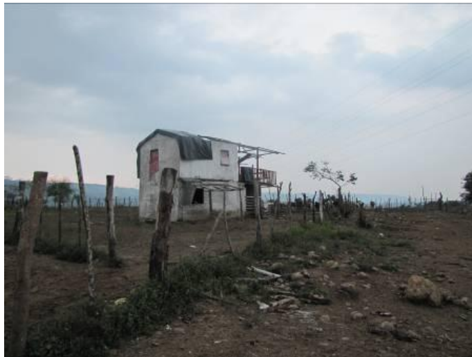
Foto No. 4.4: Vivienda abandonada en las inmediaciones de la futura S/E
