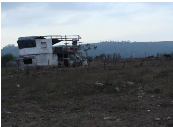
Foto No. 5.5: Vivienda abandonada en las inmediaciones de la futura S/E
