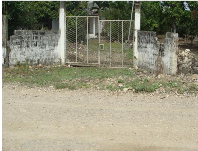
Foto No. 5.7: Camino de acceso al terreno de implantación de la S/E Chongón
