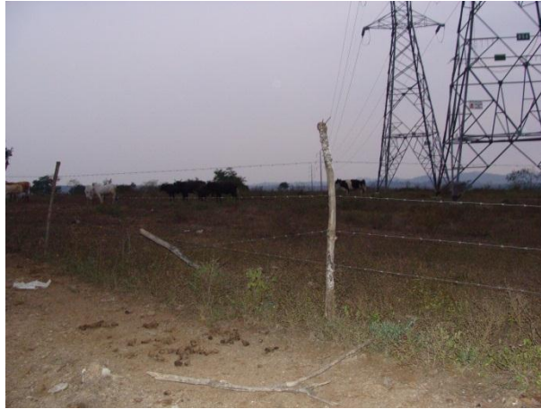
Foto No 6.1. Área destinada a la subestación Lago de Chongón – sector Aguas Negras
