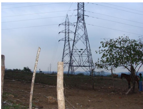
Foto No 6.3. Sector Aguas Negras – Chongón Área destinada a la subestación
