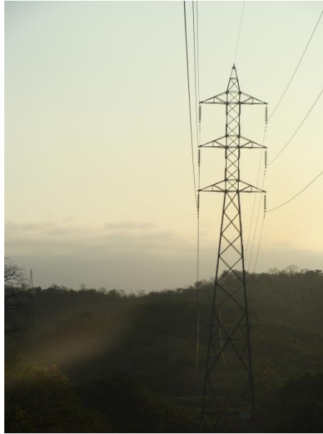
Foto No 6.2. Sector Juntas del Pacífico – planificación construcción subestación
