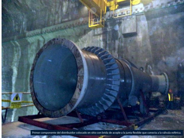
Primer componente del distribuidor colocado en sitio con brida de acople a la junta flexible que conecta a la válvula esférica.
