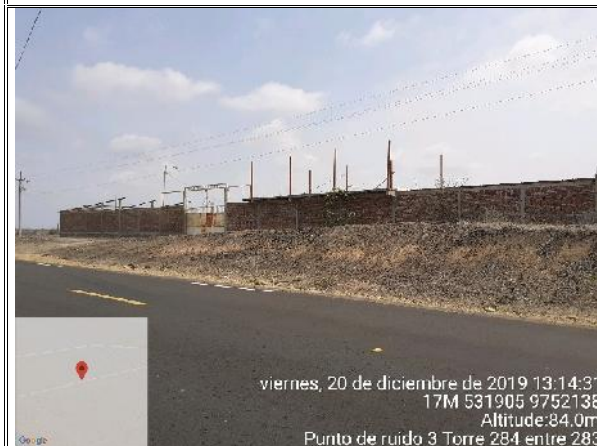
FOTO No. 31. EDIFICACIÓN ABANDONADA UBICADA ENTRE LA LÍNEAS DE LOS POSTES 284 A 283
