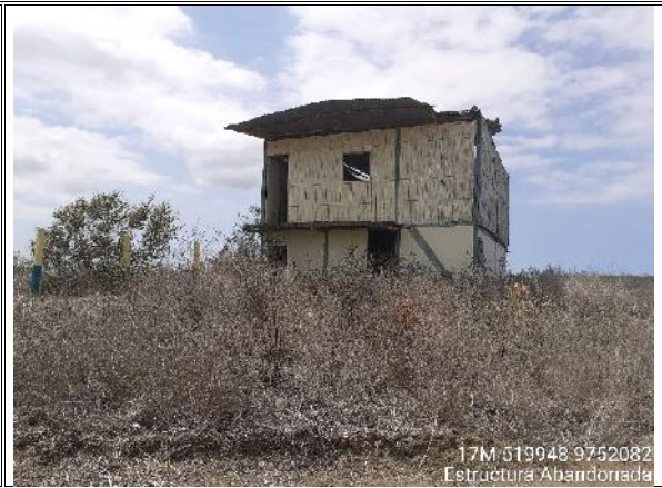
FOTO No. 30. ESTRUCTURA ABANDONADA
