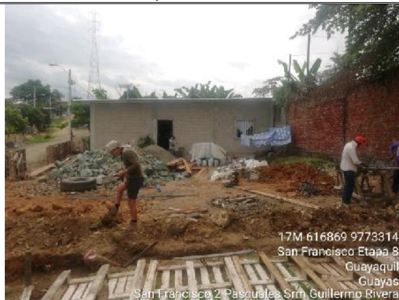
FOTO No. 60. CONSTRUCCIÓN PROYECTADA BAJO LA LÍNEA, PASCUALES, SAN FRANCISCO 2 SECTOR ALTO, 2 ENTRE E381 Y 383
