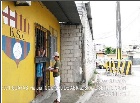
FOTO No. 44. EDIFICACIONES DENTRO DE LA FRANJA DE SERVIDUMBRE, VÍA PERIMETRAL E071
