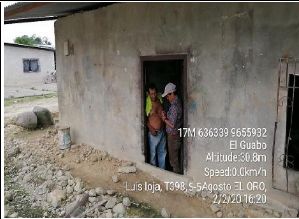
FOTO No. 35. CASA DENTRO DE LA FRANJA DE SERVIDUMBRE E047
