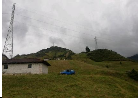
FOTO No. 7. PANORÁMICA, SECTOR LLAVIRCAY, ENTRE E017 Y E018. LT MP
