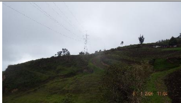
FOTO No. 3. VISTA PANORÁMICA DE LA FRANJA DE SERVIDUMBRE. LT MRT
