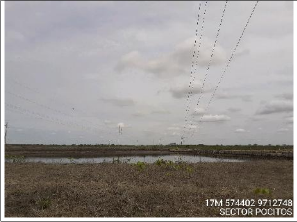
FOTO No. 16. PANORÁMICA, SECTOR POCITOS LT PP
