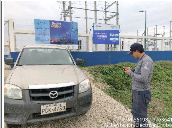
FOTO No. 25. VISITA SUBESTACIÓN CHOBO
