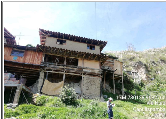
FOTO No. 32. CASA BAJO LA LT, SR. PAREDES, CUENCA, NULTI, ENTRE E142 Y E143
