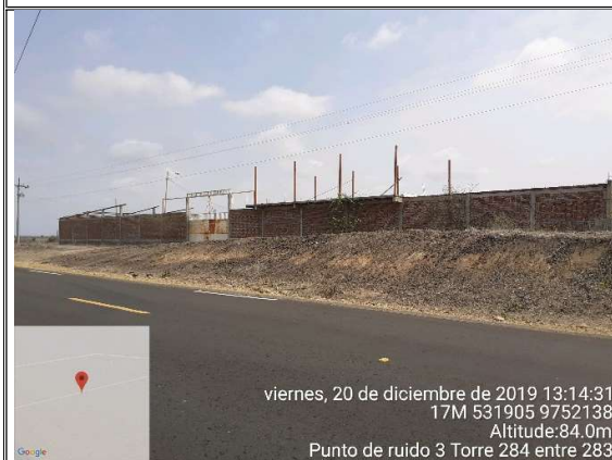
FOTO No. 40. EDIFICACIÓN ABANDONADA UBICADA ENTRE LA LÍNEAS DE LOS POSTES 284 A 283
