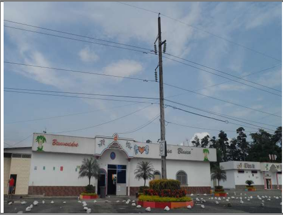
FOTO No. 47. ESTRUCTURA TIPO NIGHT CLUB PROPIETARIO ENRIQUE ORTEGA PAZZO, E239
