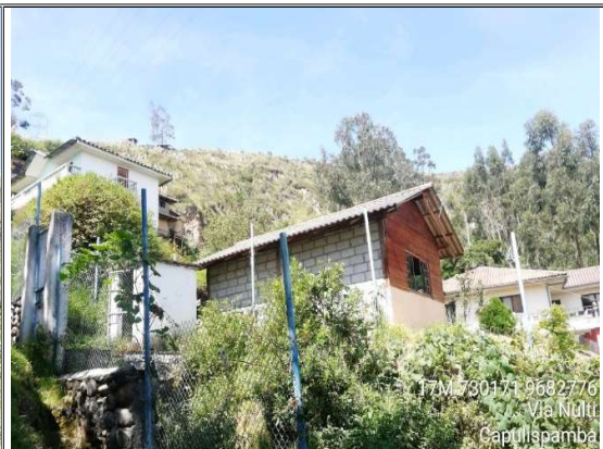
FOTO No. 33. CASA BAJO LA LT, MARCELO LUCERO, CUENCA, NULTI, ENTRE E142 Y E143
