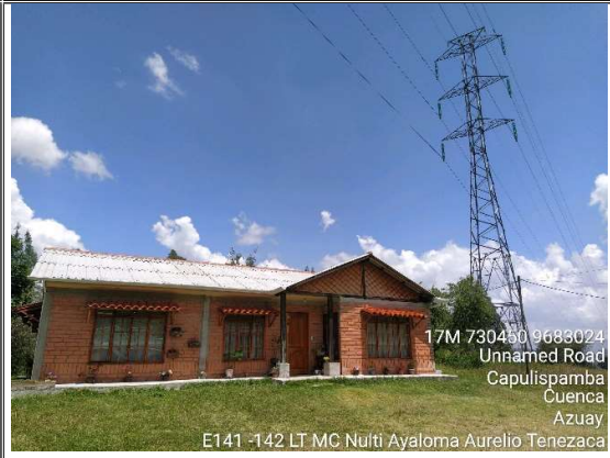
FOTO No. 25. PANORÁMICA CASA BAJO LA LÍNEA AURELIO TENEZACA, CUENCA, NULTI, AYALOMA, E142 PROBLEMA DE ESTABILIDAD
