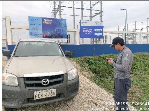
FOTO No. 15. VISITA SUBESTACIÓN CHOBO
