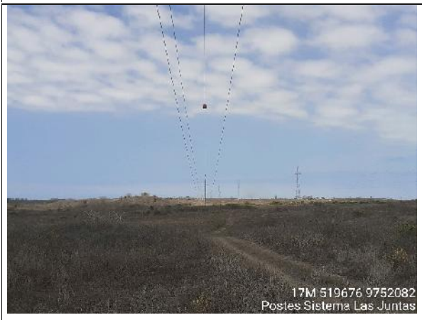
FOTO No. 6. PANORÁMICA LT JS POSTES Y FRANJA DE SERVIDUMBRE
