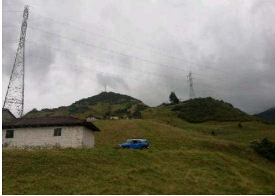
FOTO No. 13. PANORÁMICA, SECTOR LLAVIRCAY, ENTRE E017 Y E018. LT MP
