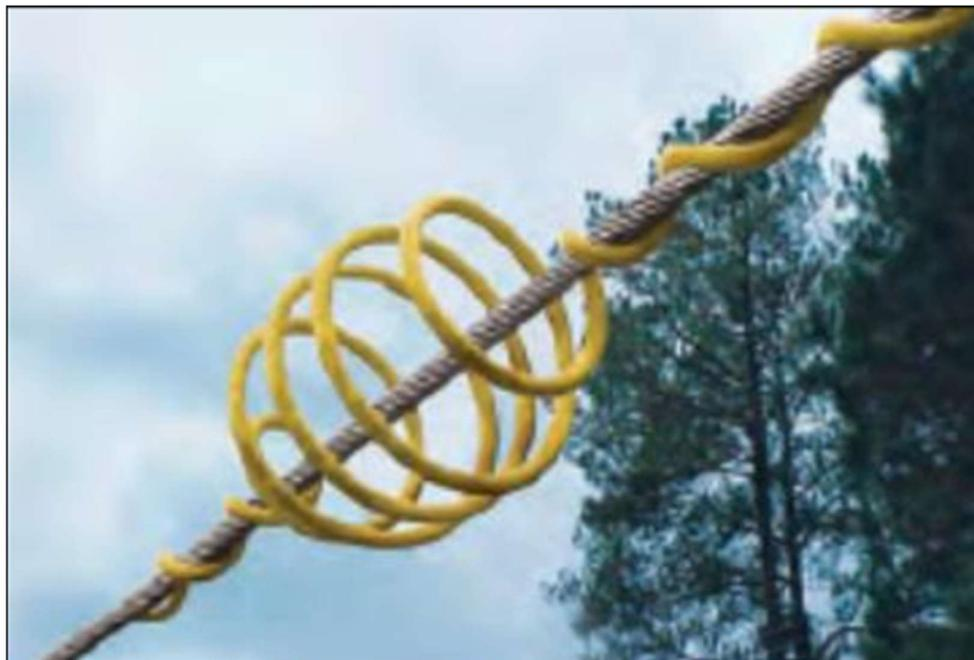
Con el objeto de asegurar la durabilidad de los dispositivos se recomienda que sean de acero inoxidable o de elementos plásticos resistentes a la luz ultravioleta, en caso de instalarse, necesariamente las inspecciones deberán describir el estado de estos dispositivos pues su vida útil necesariamente será menor que la del cable.
