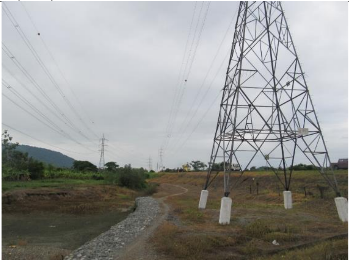
FOTO No. 5.55. COORDENADA DE REFERENCIA 653623 E 9733300 N (WG84) (WG84). VISTA SUR. RESERVA MANGLARES CHURUTE.
