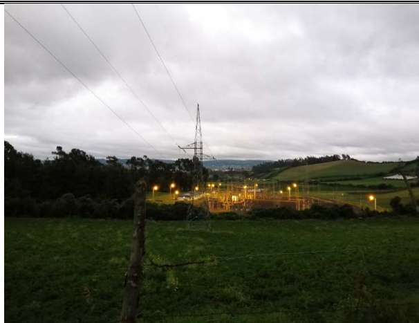
FOTO No. 5.3. PUNTO DE MONITOREO C-IT-09 LÍNEA IBARRA - TULCÁN SECTOR: SUBESTACIÓN TULCÁN – CARCHI
