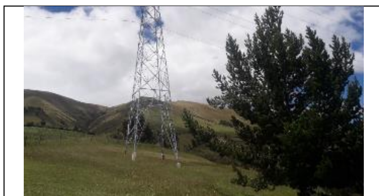
FOTO No. 5.172. E074 UBICADA EN UNA SUPERFICIE ESTABLE COORDENADAS: E 820654 - N 10015445
