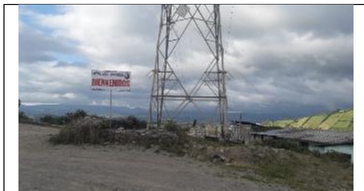
FOTO No. 5.149. E169 REQUIERE PROTECCIÓN VIAL. COORDENADAS: E 864150 - N 10082231
