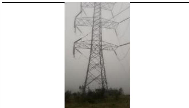
FOTO No. 5.12. E032 SE ENCUENTRA ESTABLE COORDENADAS: E 764179 - N 9950363
