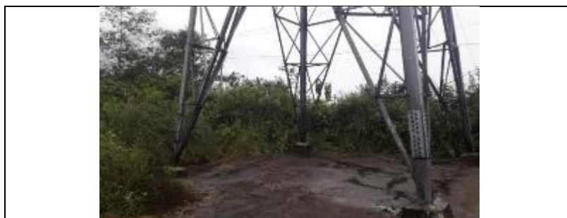
FOTO No. 5.22. E054 PRESENTA UNA LOSA DE HORMIGÓN. COORDENADAS: E 753628 - N 9951515
