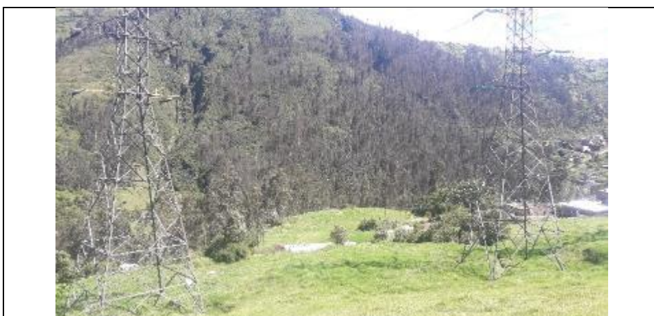
FOTO No. 5.67. TERRAZA DEL RIO MACHÁNGARA, DONDE SE IMPLANTA LA SUBESTACIÓN GUANGOPOLO. COORDENADAS: E780387 – N9976081
