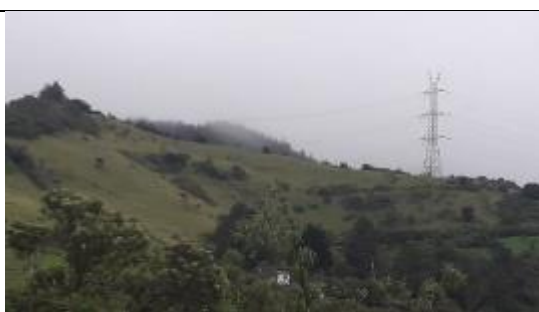
FOTO No. 5.16. E040.VISTA LATERAL COORDENADAS: E 760000 - N 9950315
