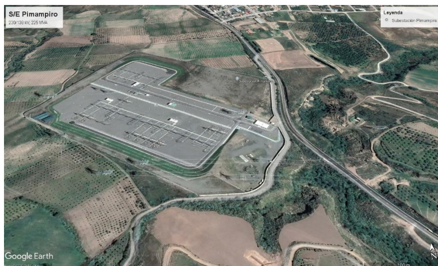
Ilustración 11. Terreno de construcción del proyecto
