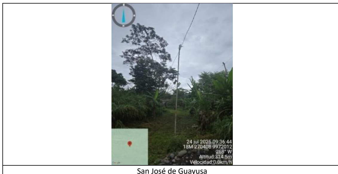
Ilustración 21. Área de construcción del proyecto
