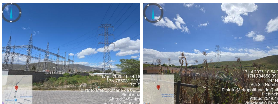
Ilustración 19. Área de construcción del proyecto
