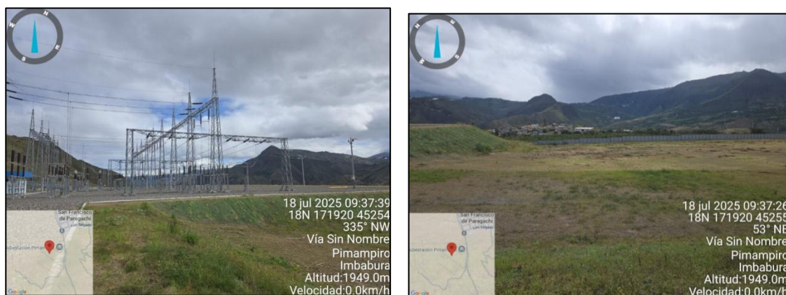
Ilustración 9. Área de construcción del proyecto
