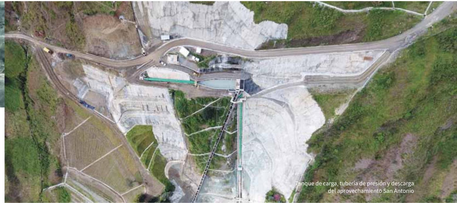
Tanque de carga, tubería de presión y descarga del aprovechamiento San Antonio
