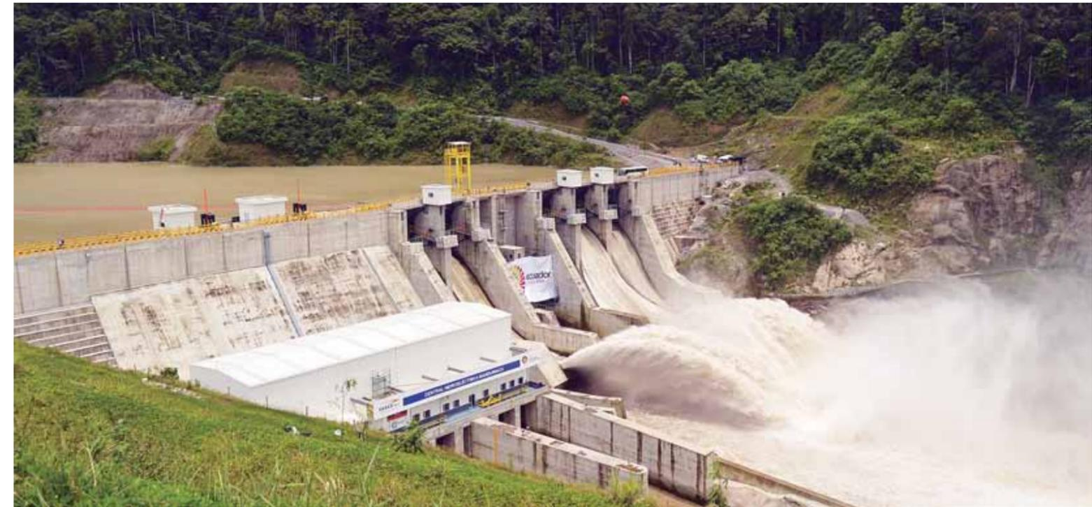
Esta central capta las aguas del río Guayllabamba mediante una presa de hormigón compactado con rodillo de 60,4 m de altura sobre cimientos, una longitud de coronación de 371 m y un ancho de 8 m. Por sus características se denomina una central de pasada.
