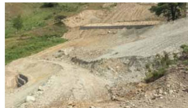
Consolidado este proceso, se intervino inmediatamente con el cierre de la escombrera protegiéndola del agua lluvia y escorrentía con el sistema de drenaje superficial y la revegetación del área (Ver figura 9). Para ésta última, se analizó física y químicamente el suelo; conocida su composición se sembró la vegetación con la aplicación de nutrientes y riego adecuados.
