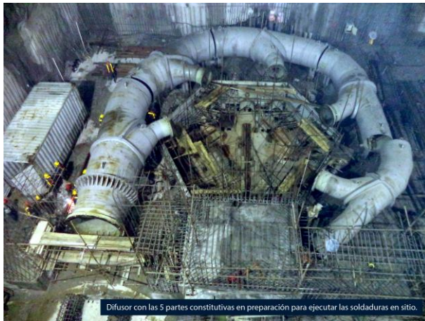
Difusor con las 5 partes constitutivas en preparación para ejecutar las soldaduras en sitio.
