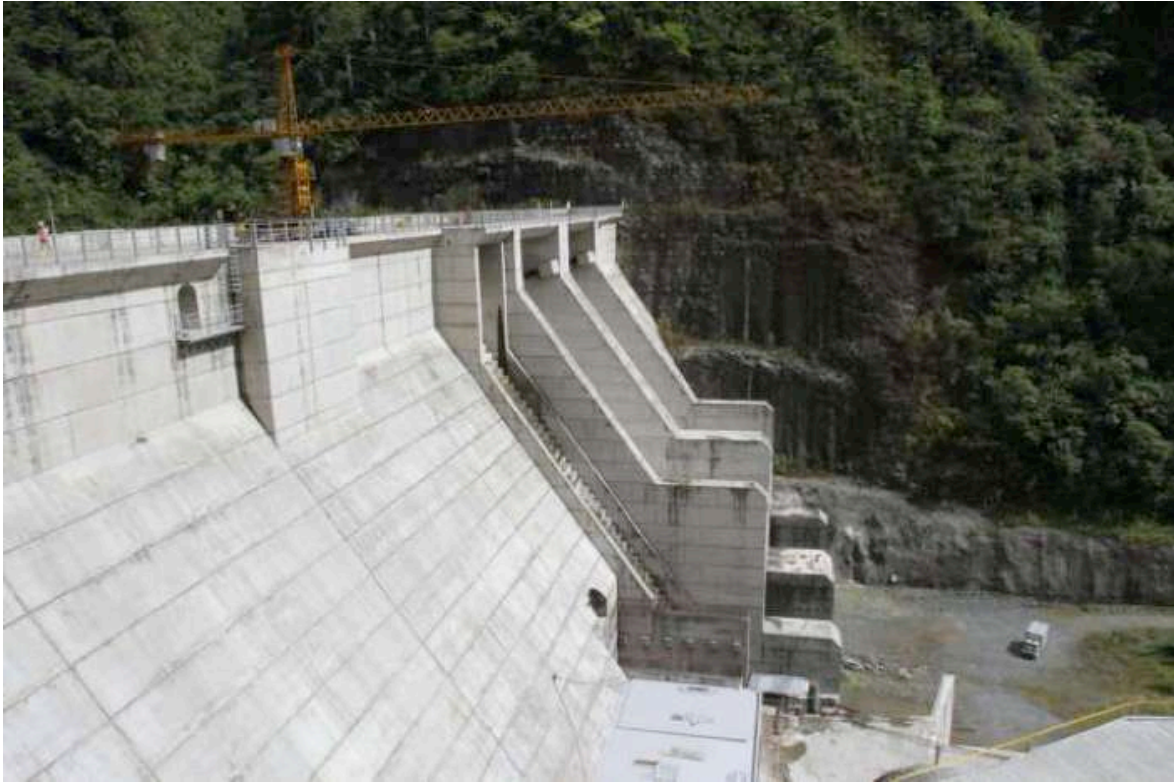
Figura Nro. 4-28: Presa del Proyecto Hidroeléctrico Toachi – Pilatón Fuente: La Hora, 01.mar.2019
