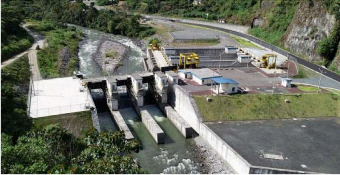
Figura No. 4-31: Captación del río Pilatón, Proyecto Hidroeléctrico Toachi – Pilatón Fuente: El Comercio, 27.feb.2019
